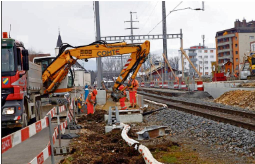
La commune de Haute-Sorne va profiter des travaux sur la ligne CFF en gare de Bassecourt pour procéder à une importante réfection de réseaux souterrains et de l'aménagement au sud des voies.
