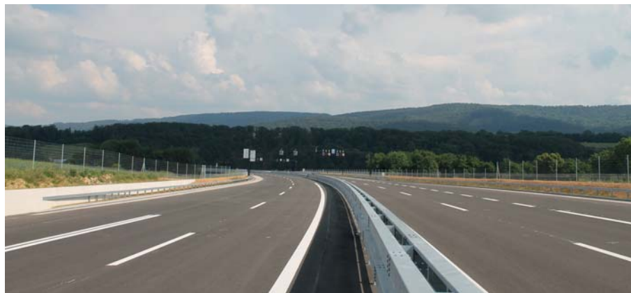
Autoroute A16-Section 2 – Tronçon tunnel de Bure – Viaduc du Creugenat.
