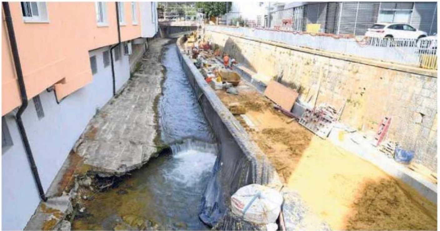
Le chantier «Centre amont» de Delémont Marée basse bat son plein. La Sorne a été coupée en deux pour travailler alternativement sur chaque moitié de rivière.
